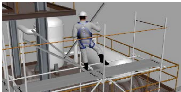
足場組立時の墜落災害
