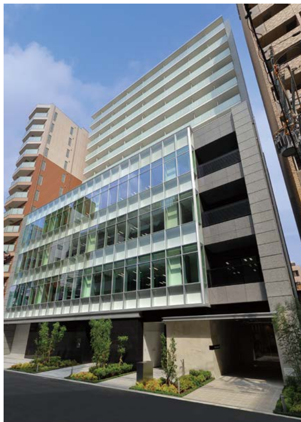
NIPPO 新 関西支店ビル (2022年9月竣工)
