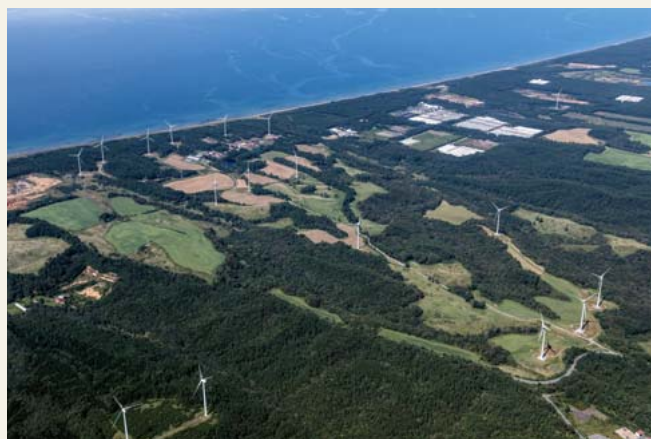
▲横浜町雲雀平風力発電所（青森県）
