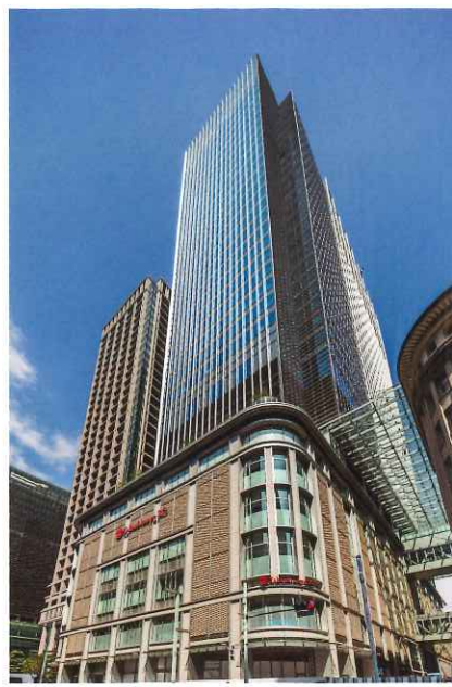
新社屋が入居する日本橋高島屋三井ビルディング
