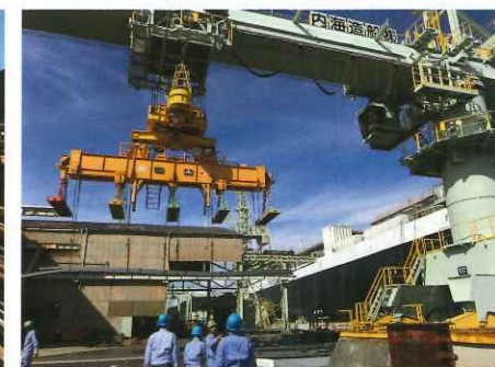
大きな鋼材を搬入するクレーン
