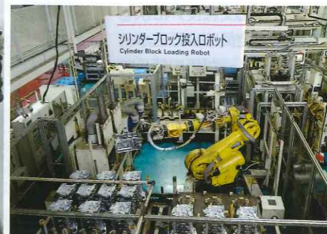
▲シリンダーブロック投入ロボット
